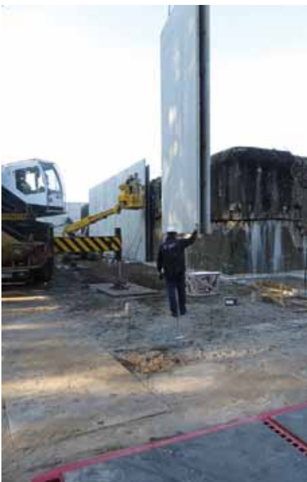
Aanbrengen beplating bunker Bilthoven
