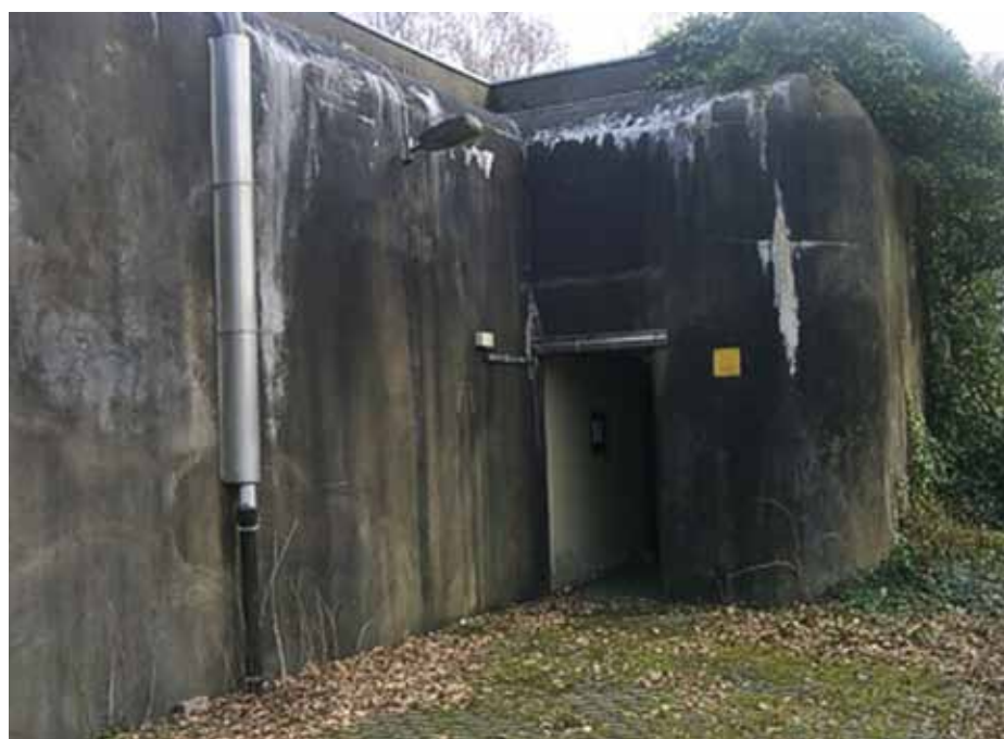
Ingang bunker Bilthoven
