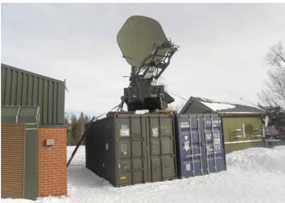
Figuur 5: De tactische trailer stevig vastgezet op de zeecontainers waardoor satcomverbinding met Noord-Noorwegen mogelijk werd. (Zie de lage opstraalhoek van de schotel)
