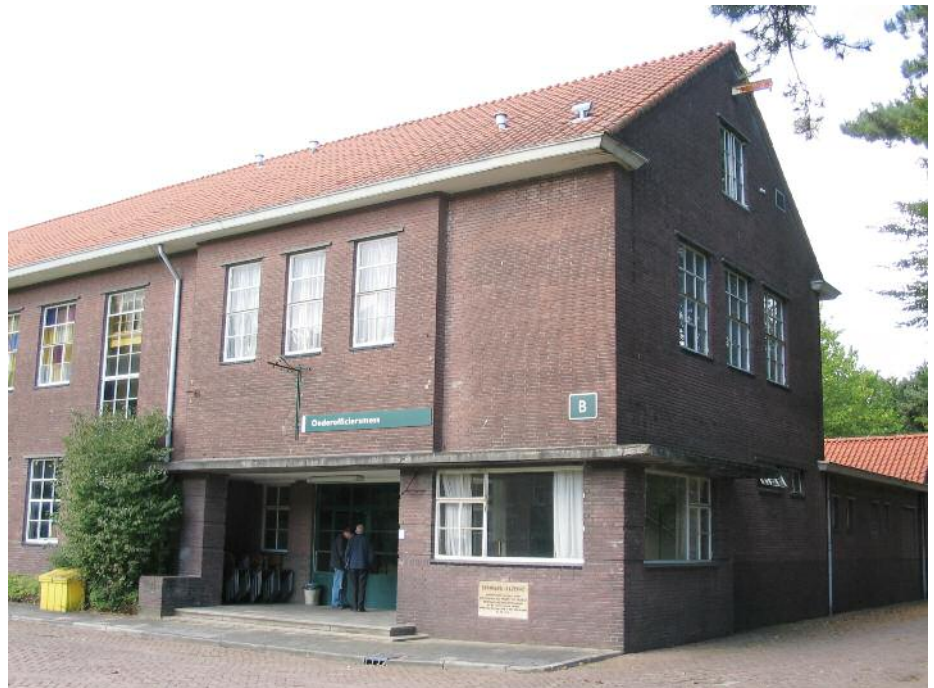
Voorkant van gebouw B
