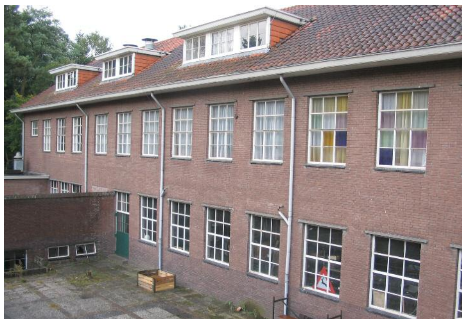
De achterkant van gebouw B
