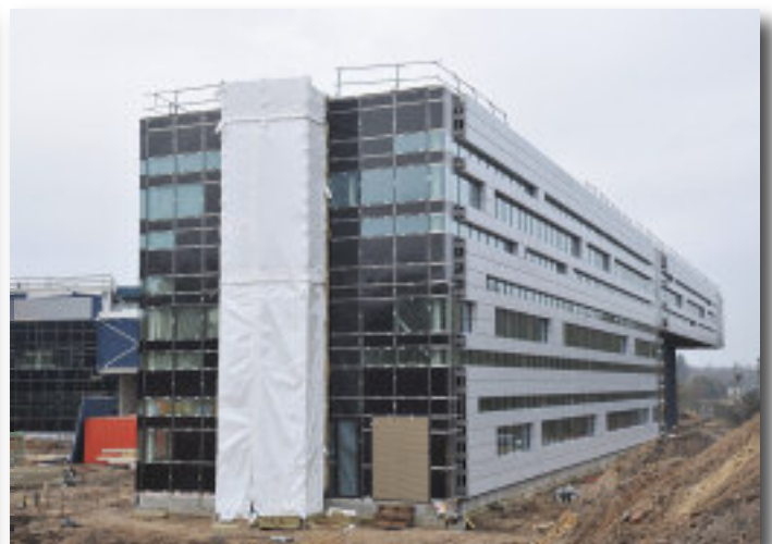
Zijleugel AC-11 aan de spoorzijde (7 feb)
