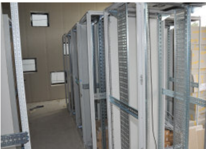
Patchkasten gereed voor montage (7 juni)
