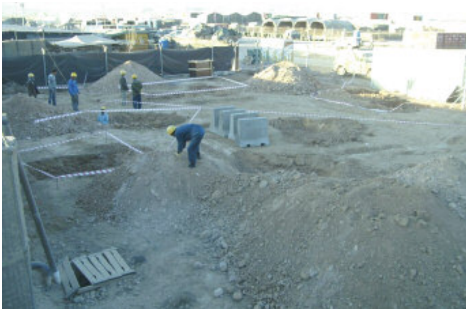
Grondwerkzaamheden en fundering voor de BICC masten
