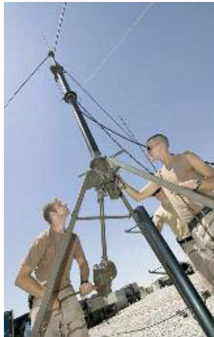
Installeren steekmast (Bron: Defensie beeldbank, AVDD, Ruud Mol)
