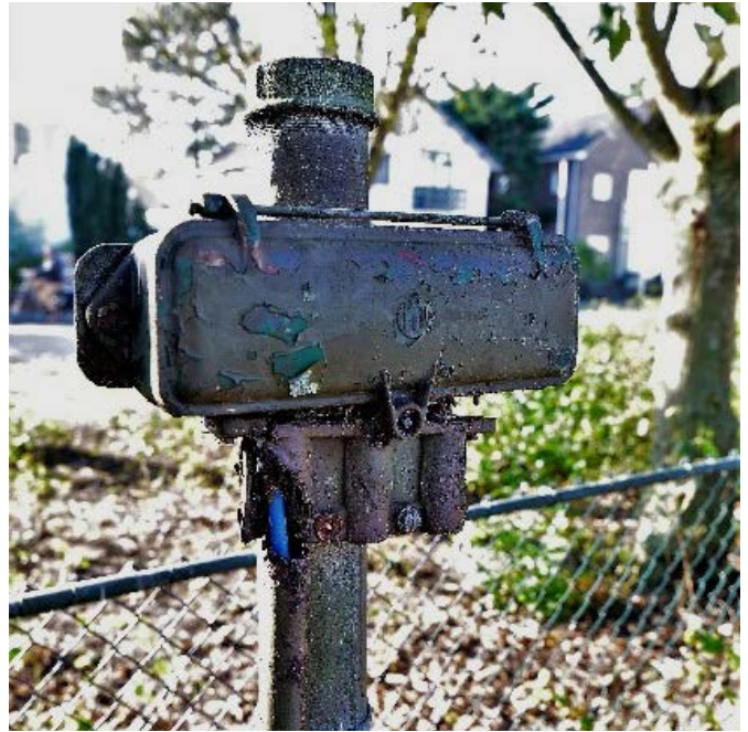
Boven: Waterdichte aansluitkast 1da gemonteerd in een metalen behuizing op het oefenterrein Gorsselseveld, anno 2019.
