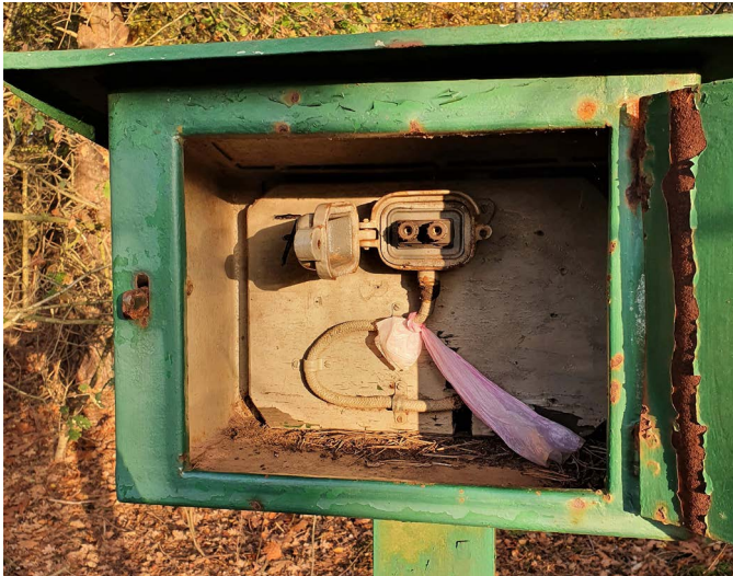
Boven: Waterdichte aansluitkast 1da gemonteerd in een metalen behuizing op het oefenterrein Gorsselseveld, anno 2019.
